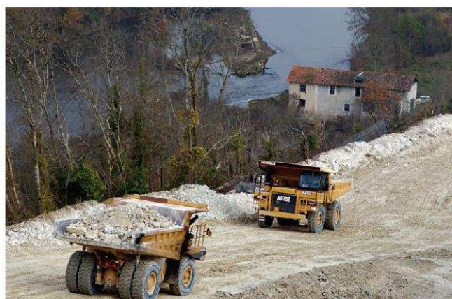
L'arrosage des pistes de chantier permet d'éviter les poussières (source : Setec)
