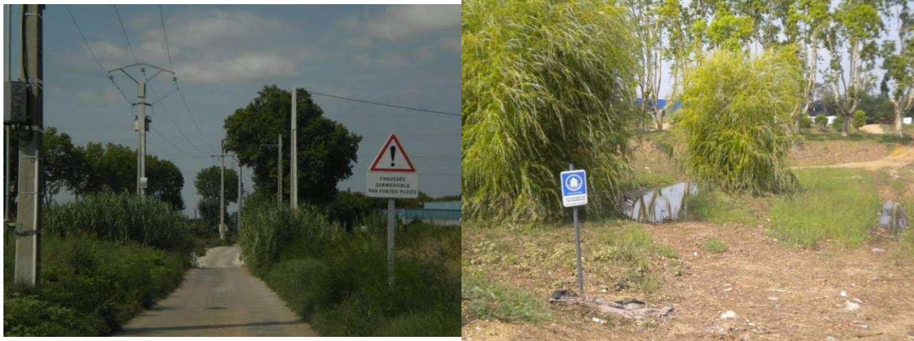
Photographie 4 : Chaussée submersible par forte pluie (rue de la Banquière, à l'ouest de la zone d'étude)
