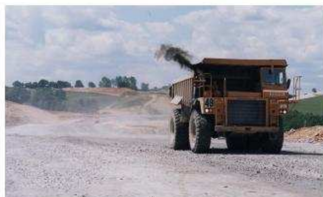
Engin de terrassement
