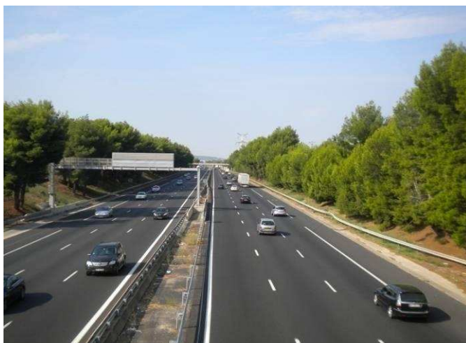
Photographie 17 : Autoroute A9 actuelle
