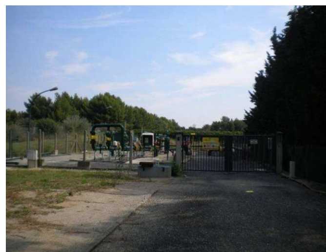
Photographie 16 : Poste de gaz Montpellier Mas Rouge
