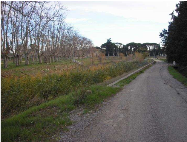
Fossé à proximité de la mogère
