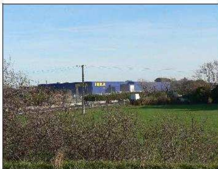
Point de vue 7 : orientation nord-est, depuis le mas de Brousse, vue sur l'autoroute et les récents bâtiments de l'enseigne IKEA.
