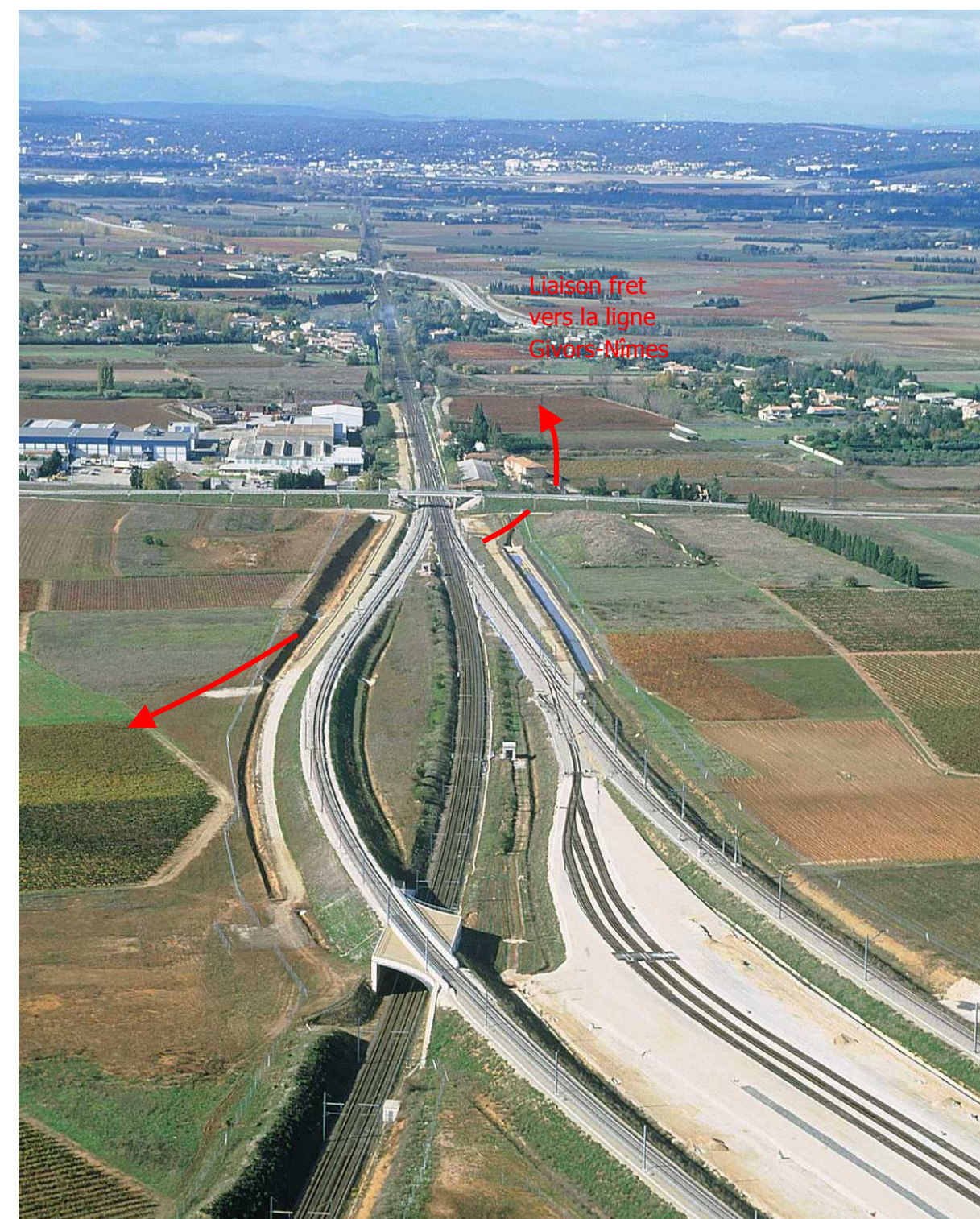
Le site de l'ouvrage sous la ligne Tarascon-Sète vu du sud-Est
