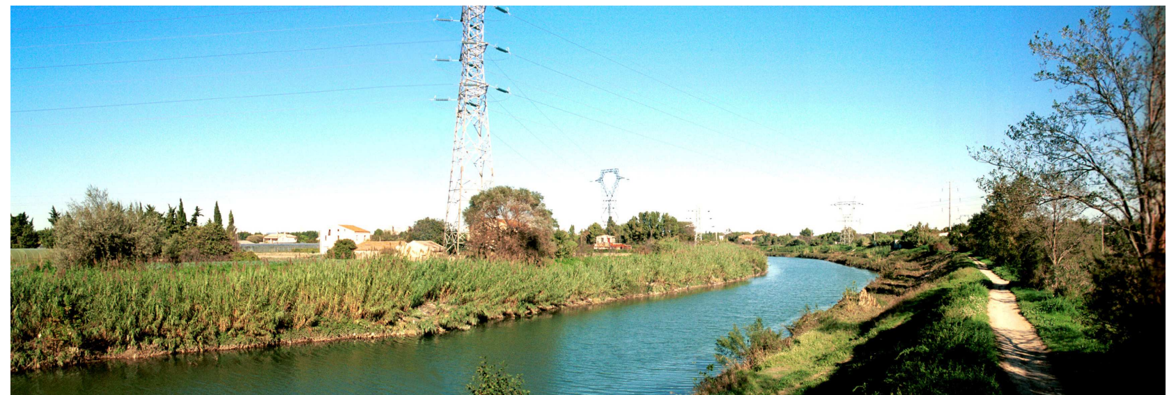
Le viaduc sur le Lez : état actuel
