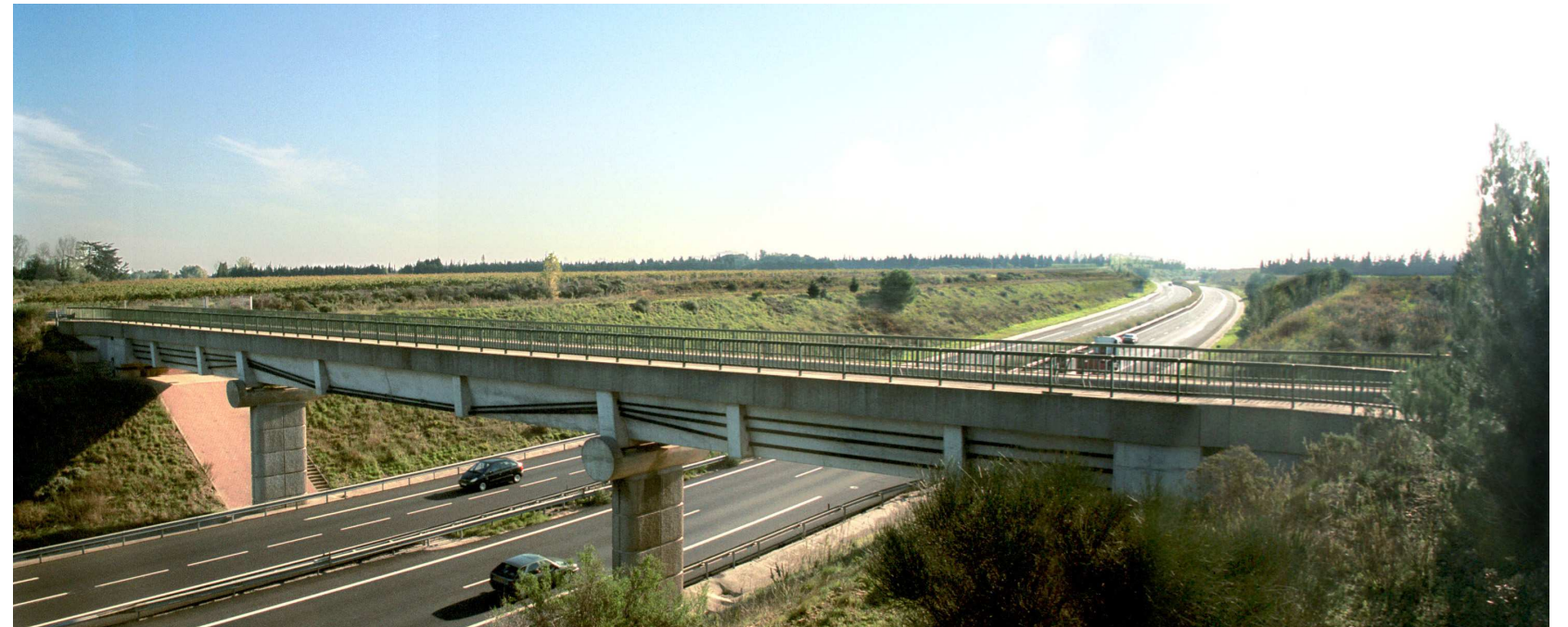
Le viaduc sur l'autoroute A54 : état actuel
