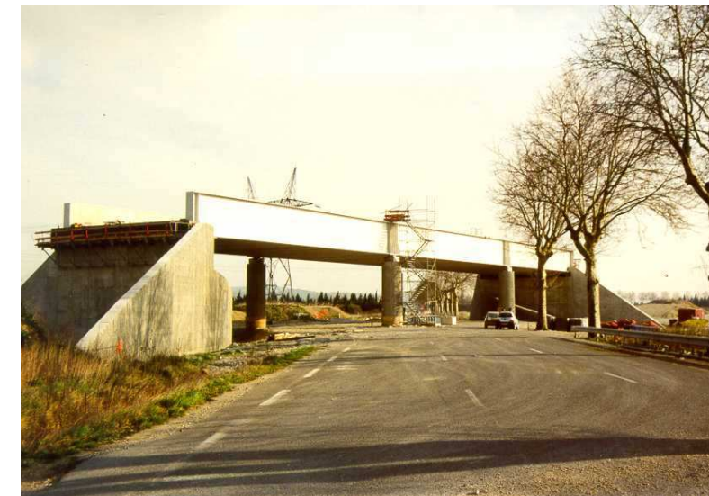
Tablier à poutres latérales : Le viaduc sur la RN7 en cours de travaux (LGV Méditerranée)
