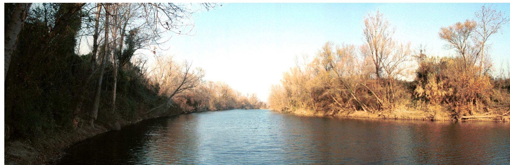
Le viaduc sur le Vidourle : état actuel
