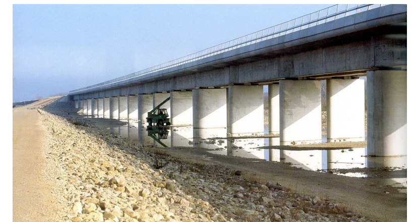
Tablier à poutres en béton : Ouvrage de décharge sur le Gardon (LGV Méditerranée)
