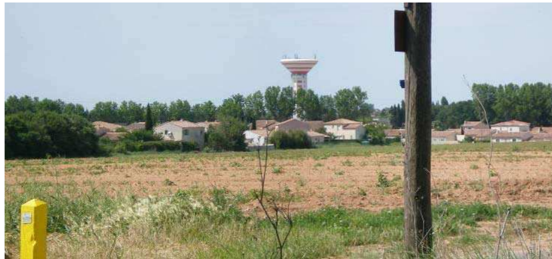
La limite bâtie franche au sud : Boirargues avec son château d'eau qui forme un élément de repère
