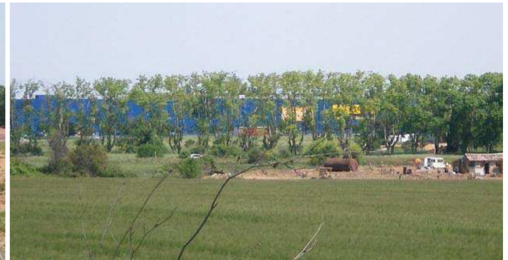
La limite nord franche au nord : les bâtiments IKEA du quartier d'Odysseum
