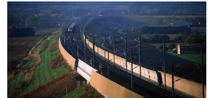
Exemple de protection acoustique à la source de type écran
