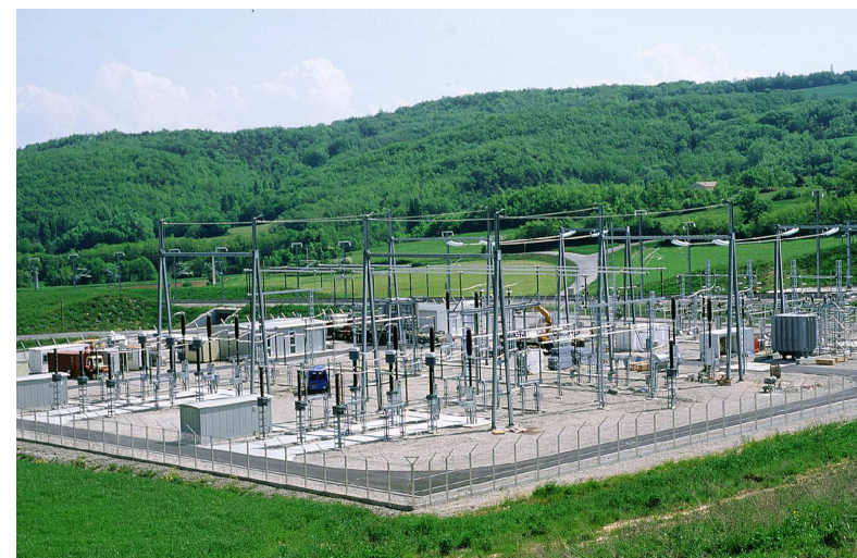
Sous-station de Chabrilan
