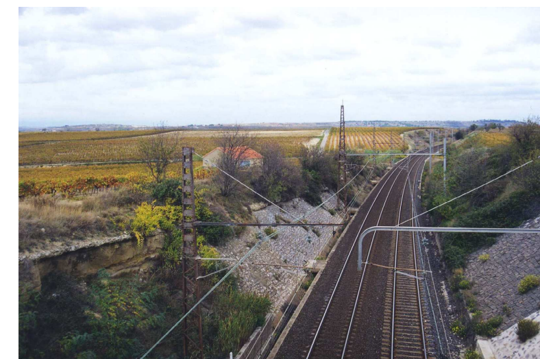
Ligne ferroviaire existante entre Montpellier et Perpignan
