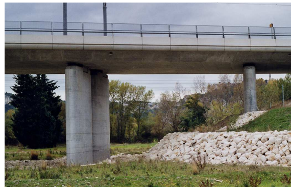
Ouvrage de décharge assurant la transparence hydraulique
