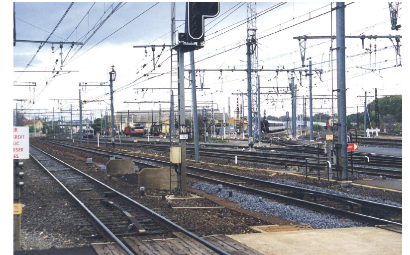
Installations existantes à Narbonne
