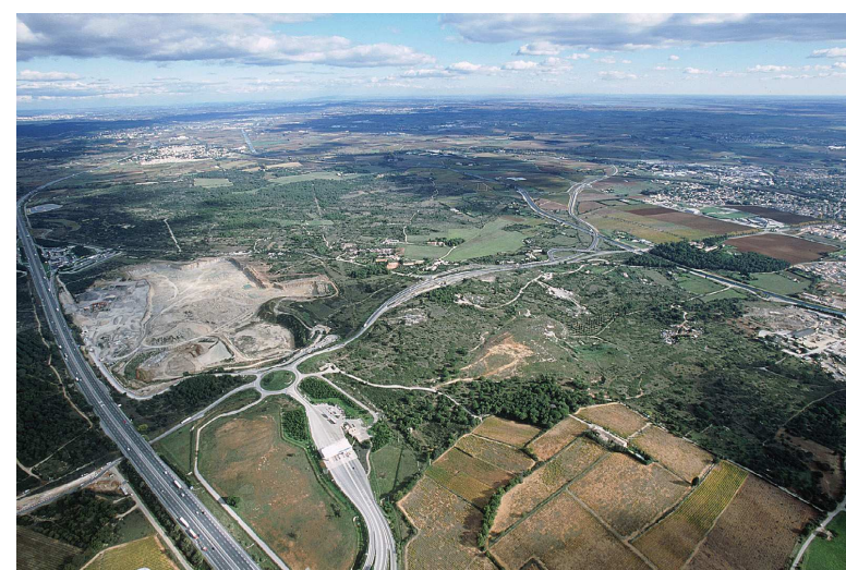
Carrière en exploitation le long de l'autoroute A9
