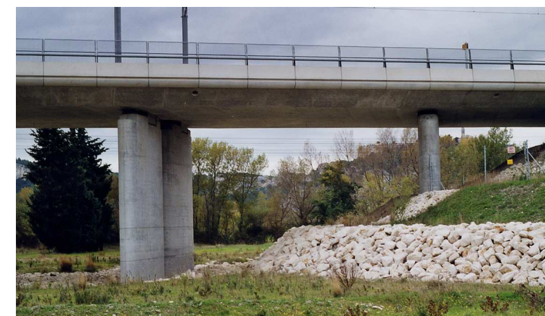
Ouvrage hydraulique sur la Durance (LGV Méditerranée)
