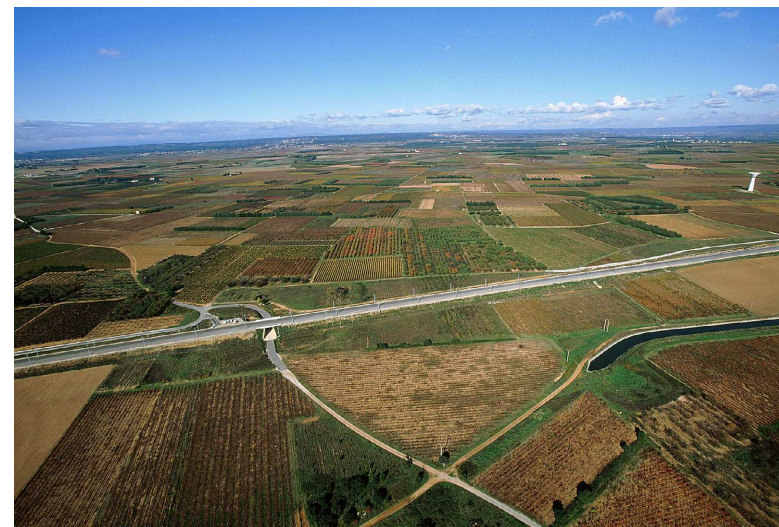
Zone de franchissement de la LGV Méditerranée
