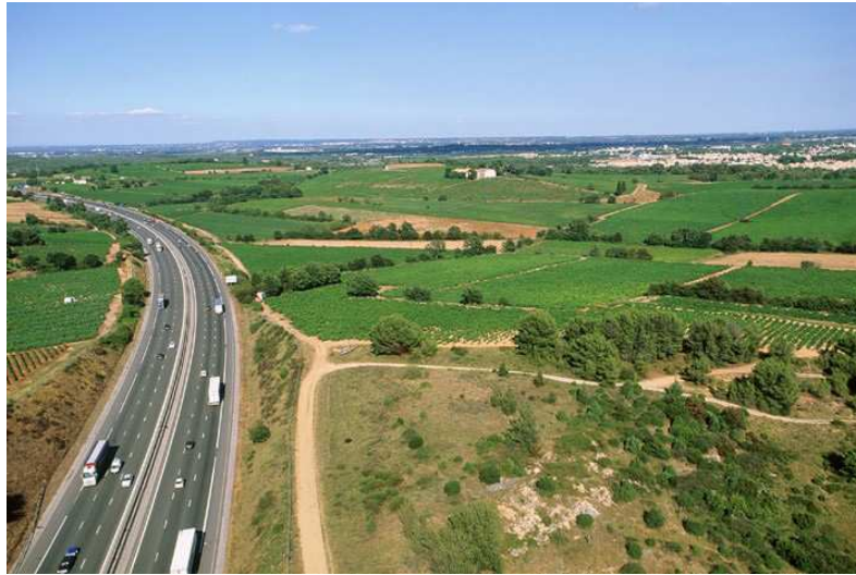
Entre l'autoroute A9 et Lunel-Viel
