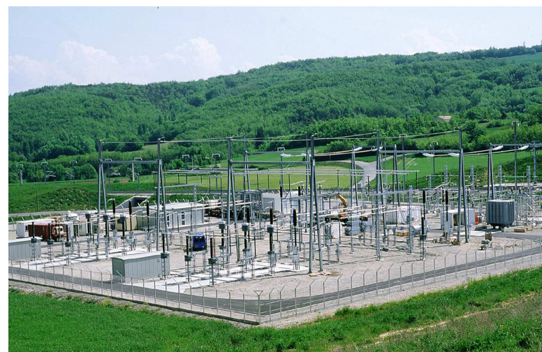
TGV Méditerranée - Sous-station de Chabrilan
