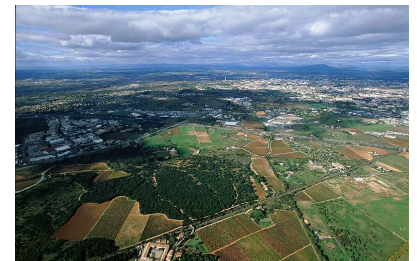
Secteur de raccordement à Lattes
