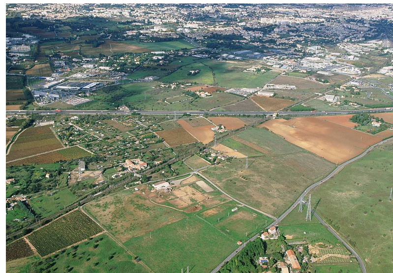
Site d'implantation de la sous-station de Lattes
