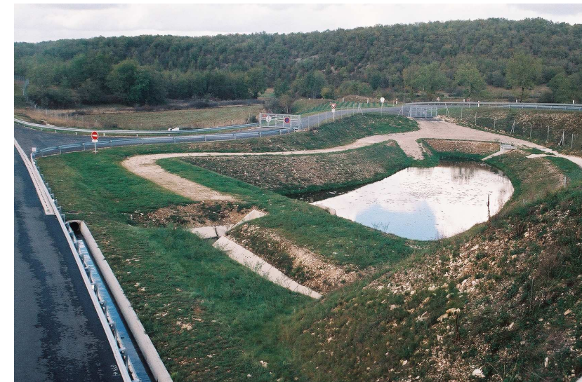
Exemple de bassin mis en place sur autoroute
