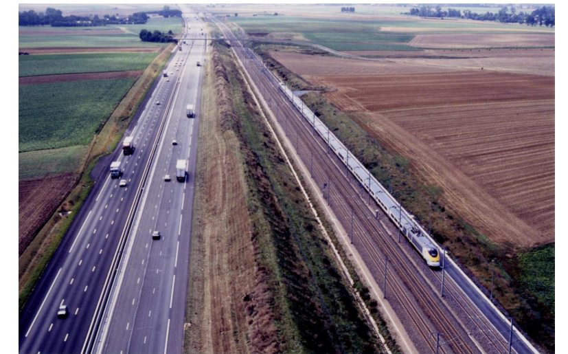
Exemple de jumelage avec merlon de séparation
