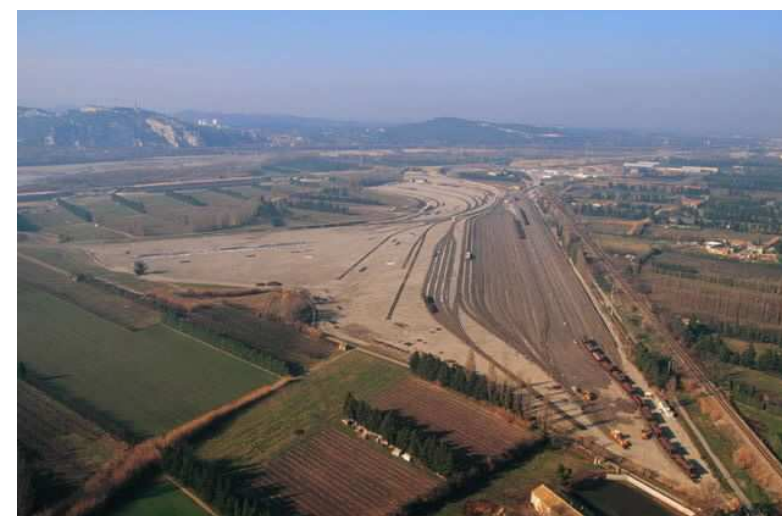
Base travaux de Cheval Blanc (Vaucluse)
