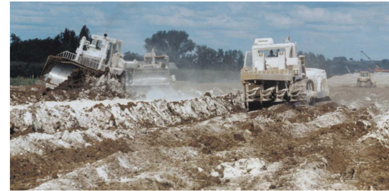
Epandage de liants hydrauliques (chaux)
