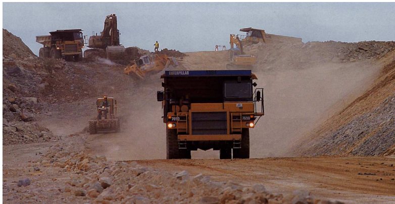
Circulation d'engins sur les plates-formes de terrassement
