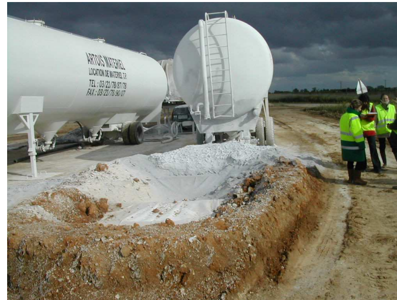
Matériel et dispositifs utilisés lors de l'utilisation de chaux sur les chantiers
