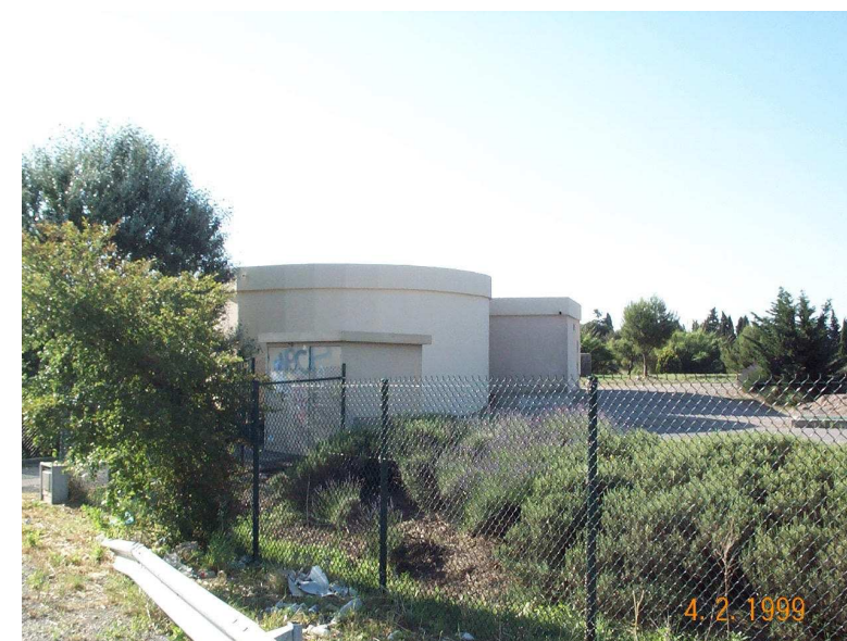
Captage d'alimentation en eau potable
