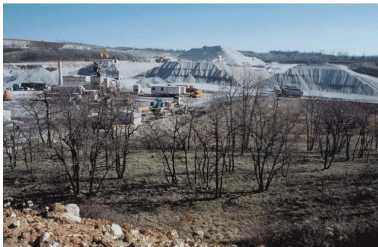
Installations de chantier aux abords d'une zone de stockage de matériaux
