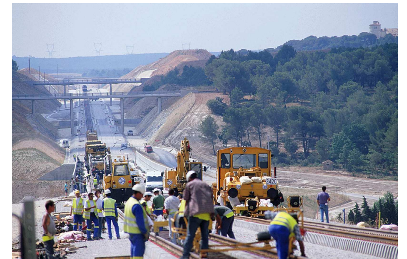
Travaux de construction du TGV Méditerranée
