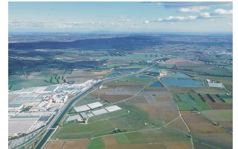
L'usine Perrier de Vergèze
