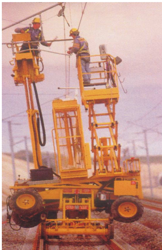
Travaux sur la LGV Méditerranée - Pose de caténaires
