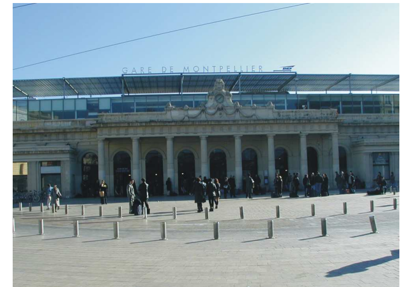
Gare de Montpellier
