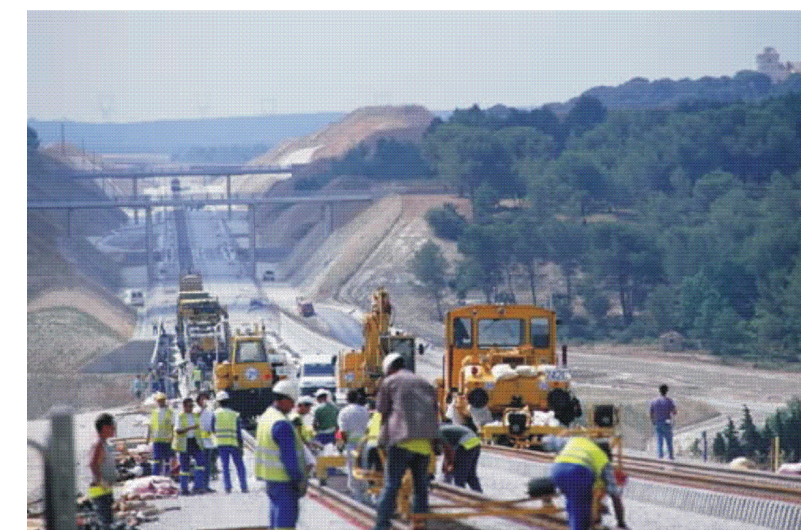
Pose de voie sur le chantier de la LGV Méditerranée
