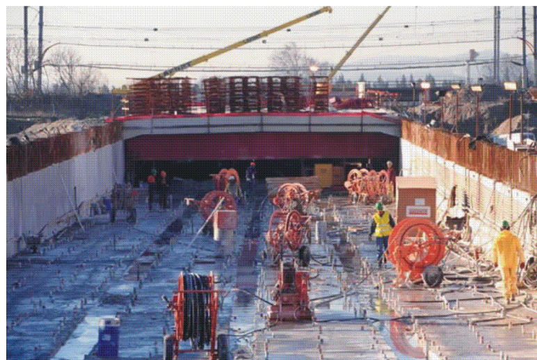
Chantier de la LGV Méditerranée
