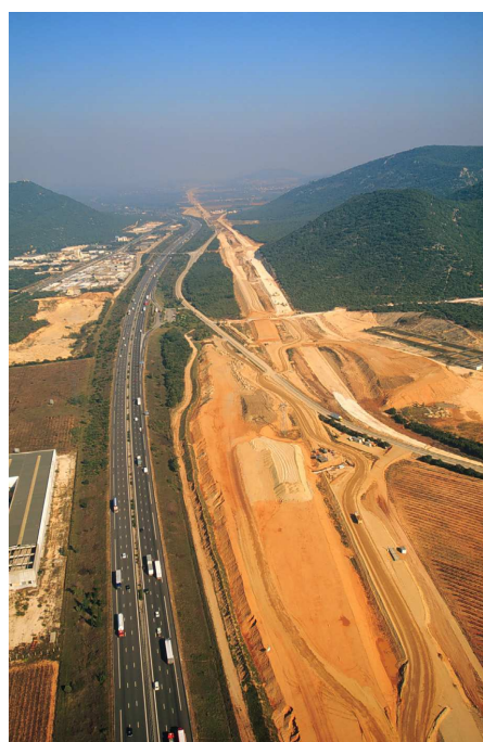
LGV Méditerranée : travaux de terrassements
