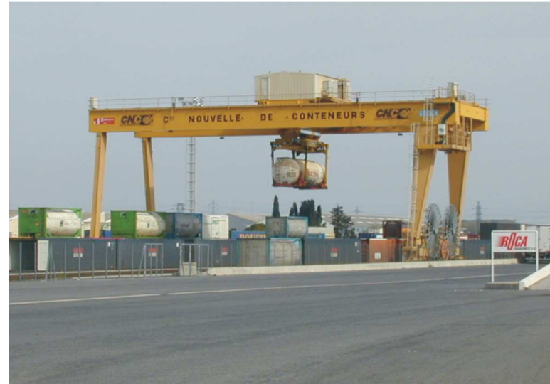
Chantier de Transport Combiné de Perpignan Saint Charles
