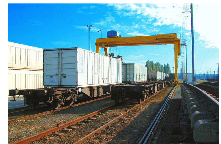
Chantier de Transport Combiné de Perpignan
