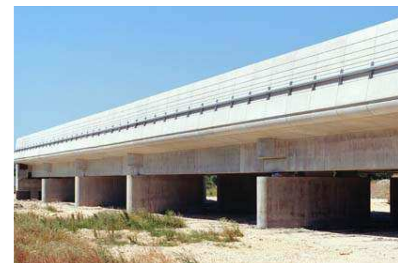
Ouvrage hydraulique « Les Cavallères » à Roquemaure LGV Méditerranée
