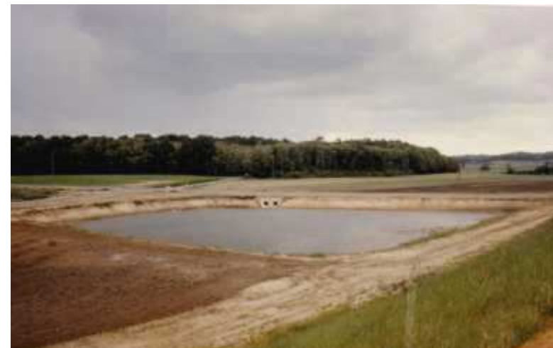
Bassin de rétention
