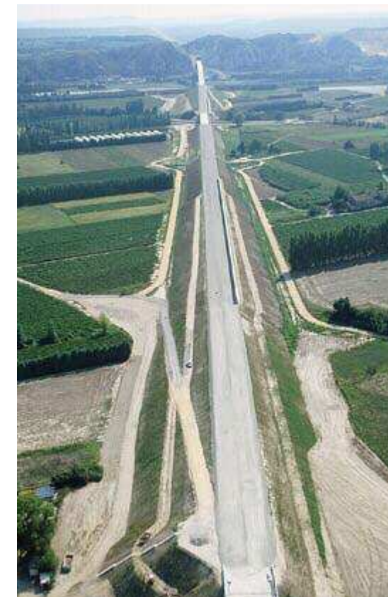
LGV Méditerranée : remblai à Roquemaure
