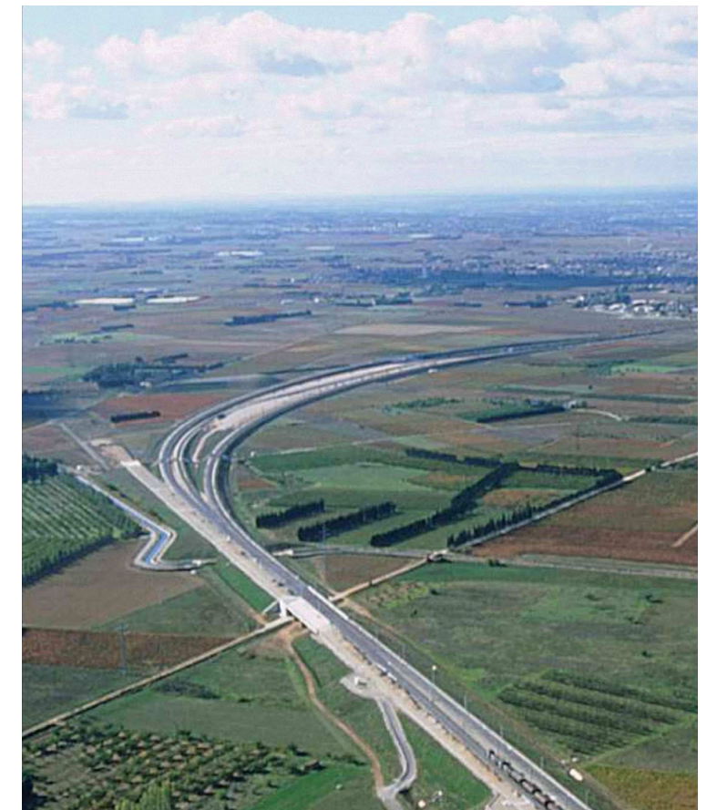
Manduel : amorce de plate-forme réalisée dans le cadre des travaux de la LGV Méditerranée en prévision du prolongement de la ligne.
