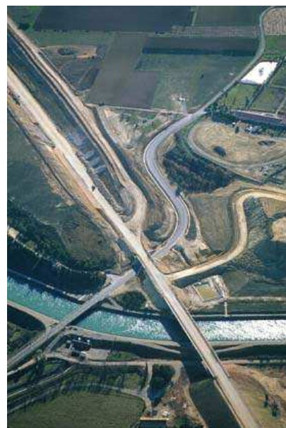
LGV Méditerranée : franchissement du canal EDF à Alleins
