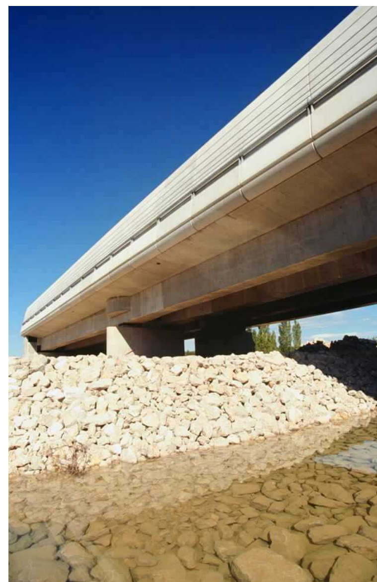
LGV Méditerranée : ouvrage de décharge (Commune de Roquemaure)
