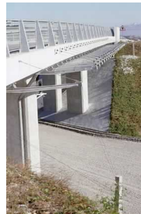
Dispositif de protection anti-chutes de véhicules sur pont-route
