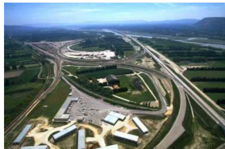
Base travaux et base vie de Cheval Blanc sur la LGV Méditerranée
