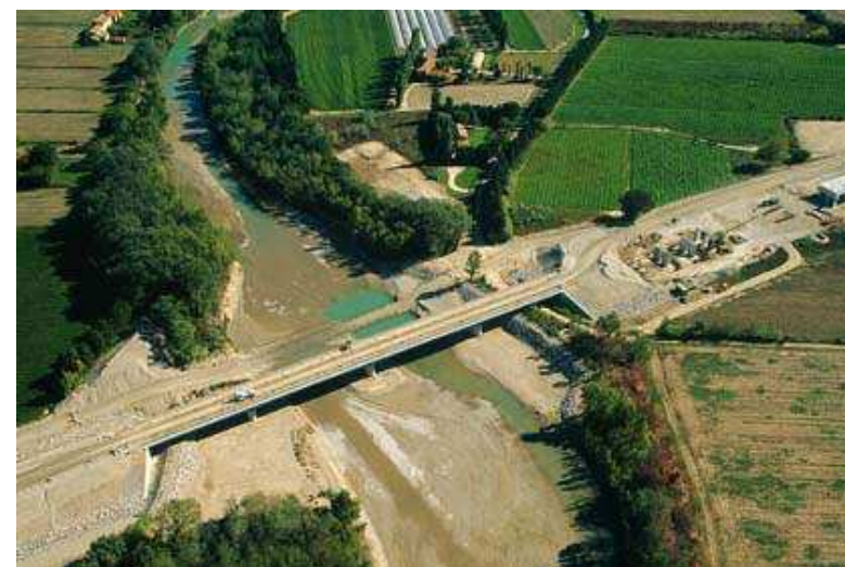
Franchissement de l'Aigues par la LGV Méditerranée à Orange
