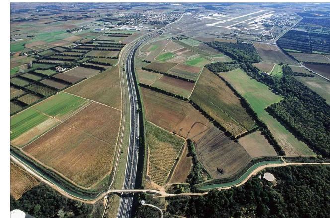
Le secteur de passage du projet au Nord de l'aéroport de Nîmes-Garons
