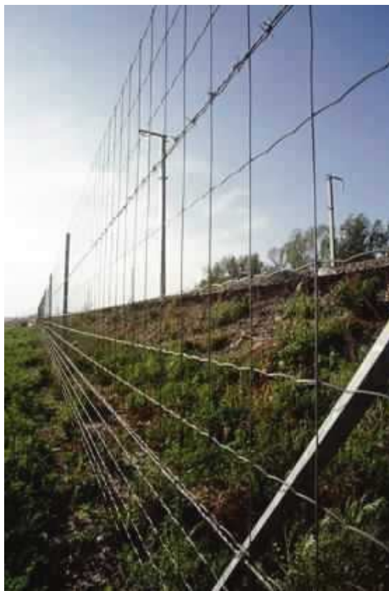
Clôture grillagée sur la LGV Méditerranée
