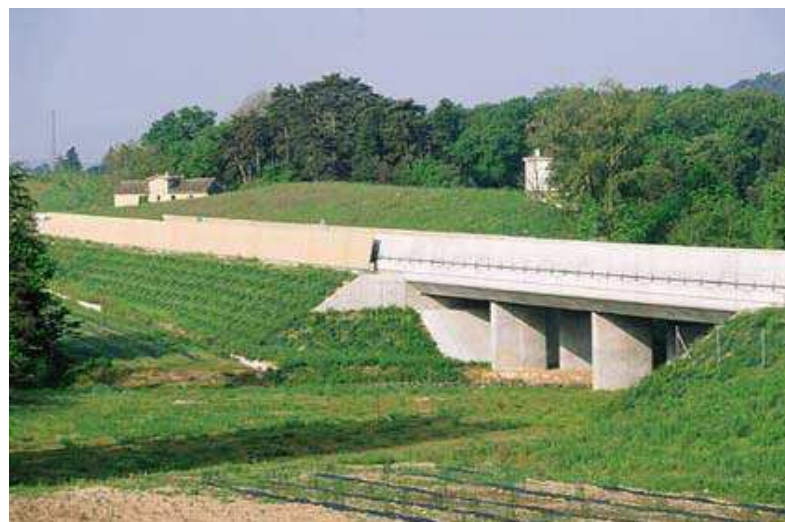
Ouvrage hydraulique de la LGV Méditerranée à Espeluhe
