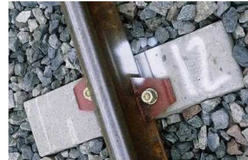
Fixation du rail sur traverse béton par des attaches élastiques
