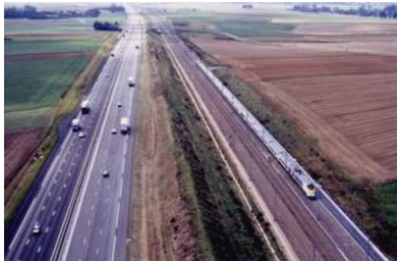
Exemple de jumelage avec merlon de séparation
