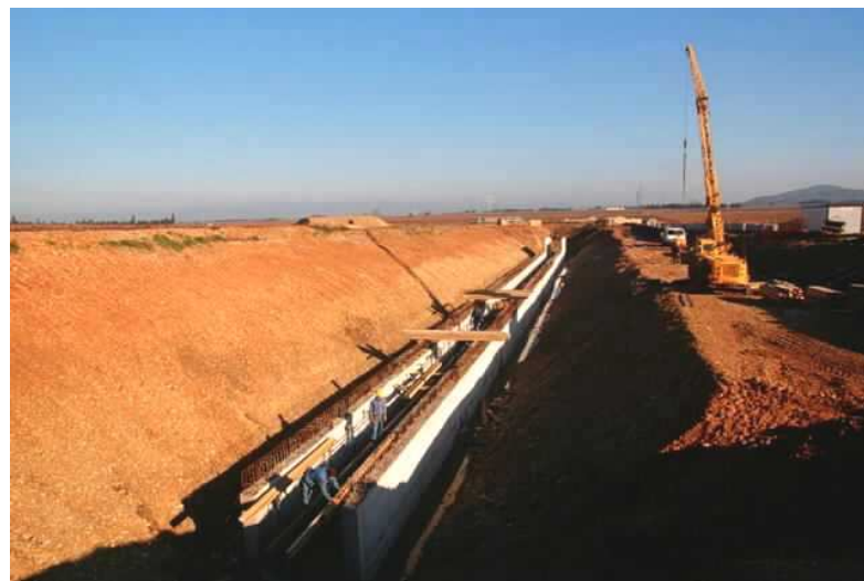
Rétablissement d'une conduite d'eau potable (LGV Méditerranée)
