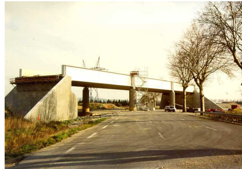
LGV Méditerranée : viaduc sur la RN 7 à Bollène
