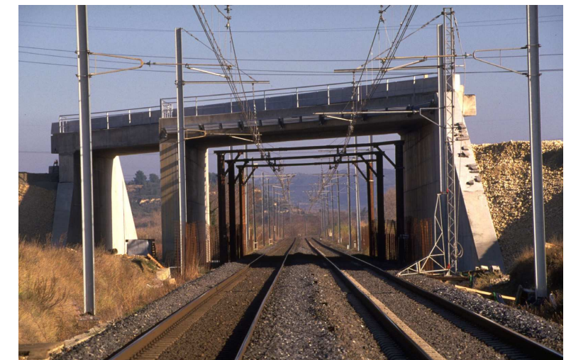
LGV Méditerranée : portique sur la ligne de rive droite du Rhône à Théziers
