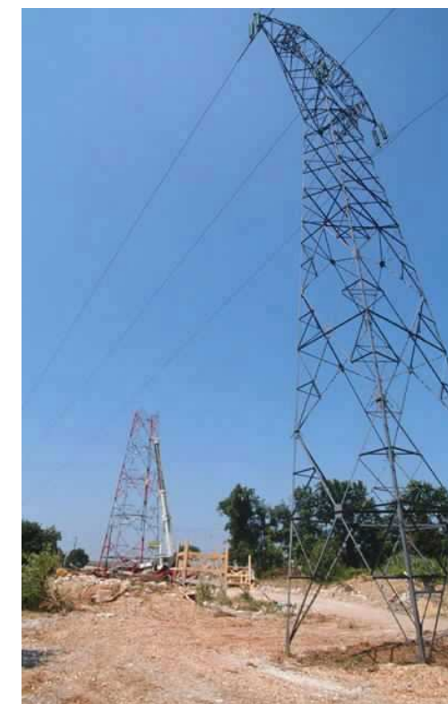
Surélévation d'un pylône haute tension sur la LGV Méditerranée
