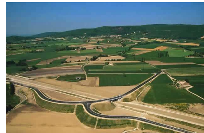
Exemples de rétablissements routiers
