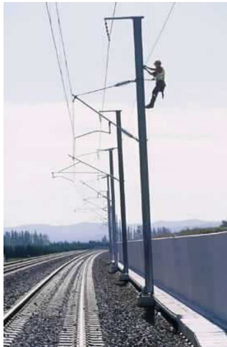
Poteau caténaire classique
