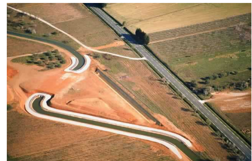
Rétablissement par siphon du canal des Costières sur la LGV Méditerranée
