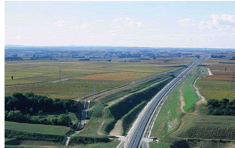
LGV Méditerranée : déblai de Comps
