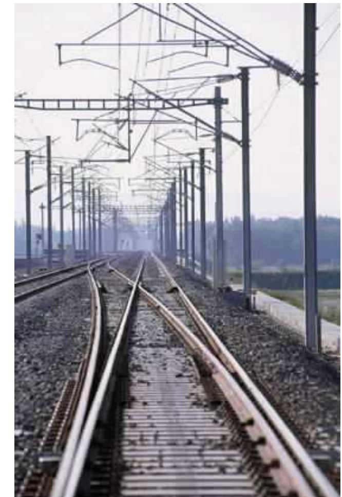
Appareil de voie (aiguillage)
