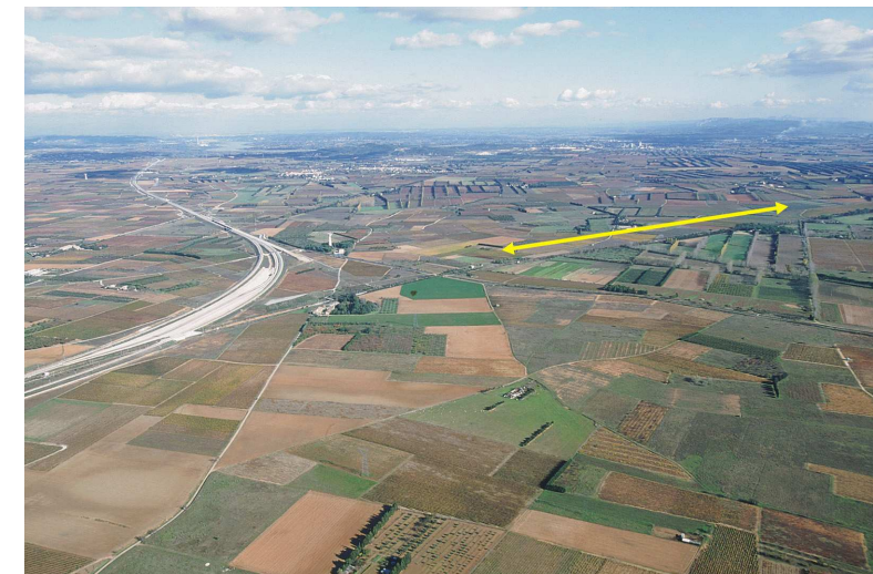
Raccordement de la LGV Méditerranée à la ligne Tarascon/Sète
