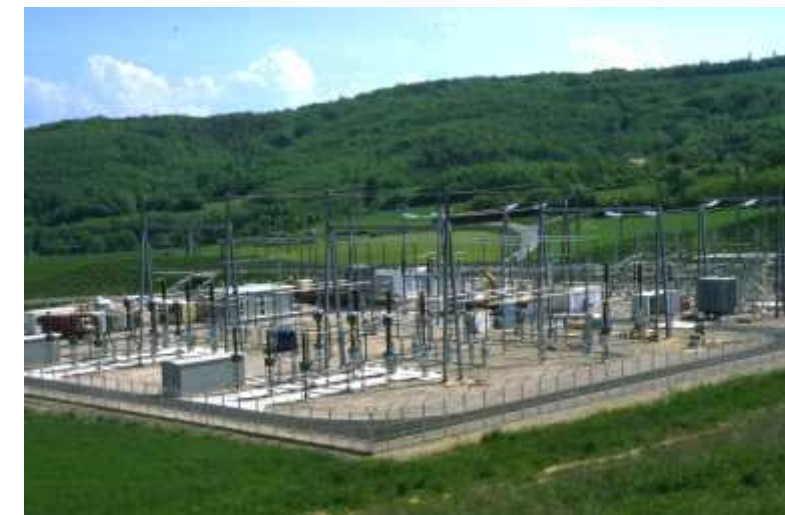
Sous-station de Chabriland (LGV Méditerranée)
