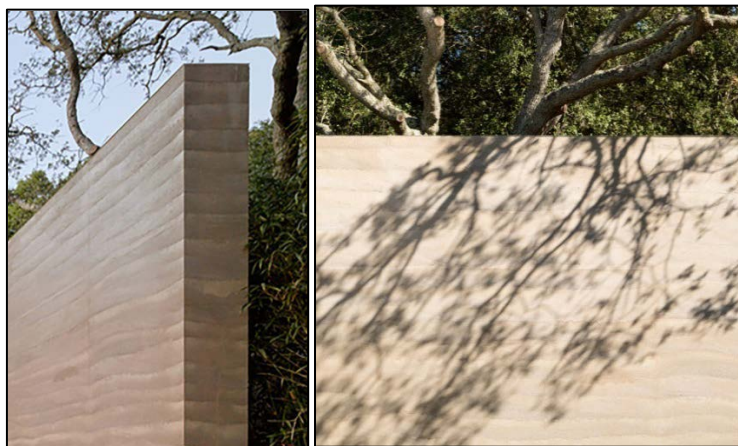
Figure 43 : parements en terre coulée
