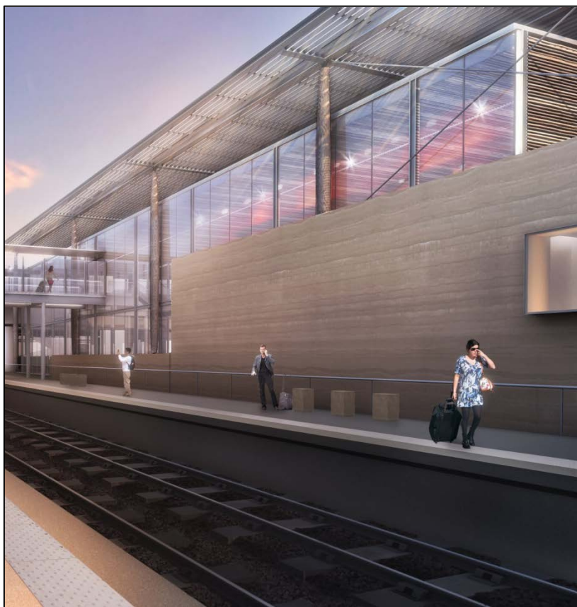
Figure 44 : mur en terre coulée sur les quais de la ligne existante
