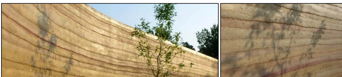
Figure 31 : exemple de clôture minérale en béton de terre
