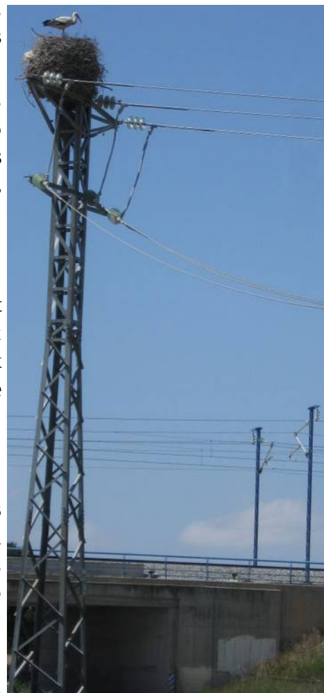
Cigogne sur pylône 20 kV, près du TGV à La Cartuja Baja (Saragosse)
